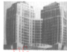
图6 用广角镜头拍摄的建筑物
